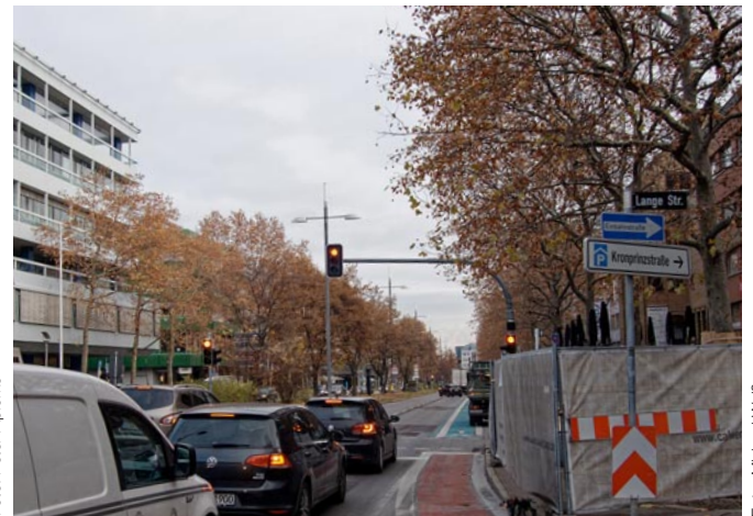
Neue Farbe – alte Gefahren.
